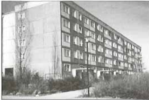
Damals moderne Blockbauweise im Stadtteil Silberhöhe.
