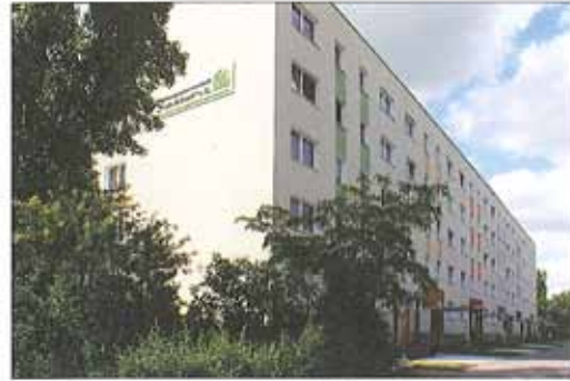
Heute die Fassadensanierung in der Weißenfeller Straße 40-50.
