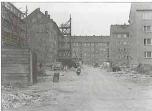
Blick in die Philipp-Reis-Straße während des Aufbaus.
